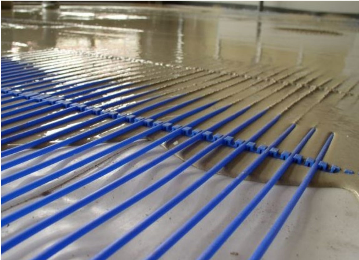
► Ogrzewanie matami kapilarnymi w warstwie wylewki
