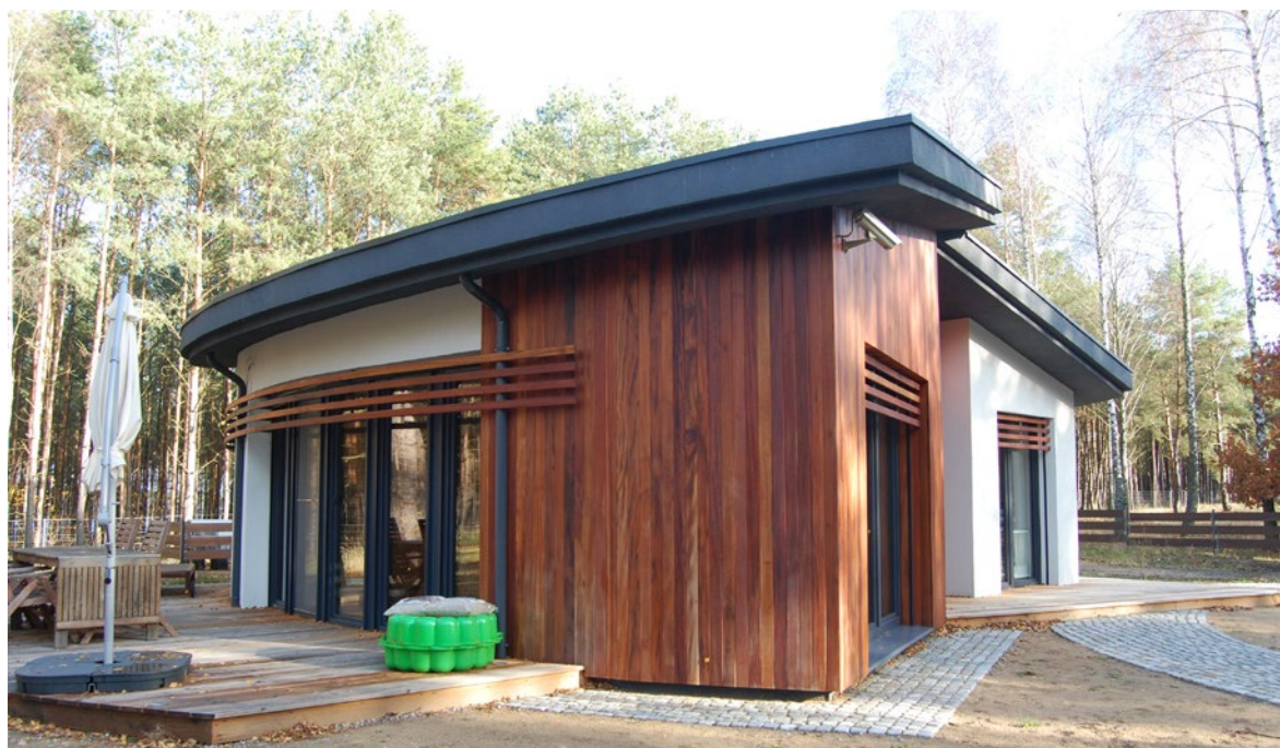
► Realizacja domu pasywnego Żagiel
