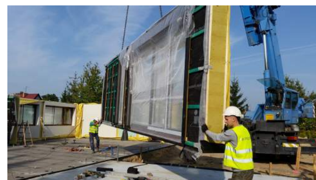
▲ Montaż domu pasywnego w Poznaniu
