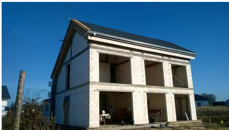
▲ Budowa domu pasywnego, fot. Katarzyna Jarocka
