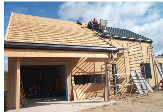
► Dach STEICO - pokrycie płytą STEICOuniversal w Komornikach
