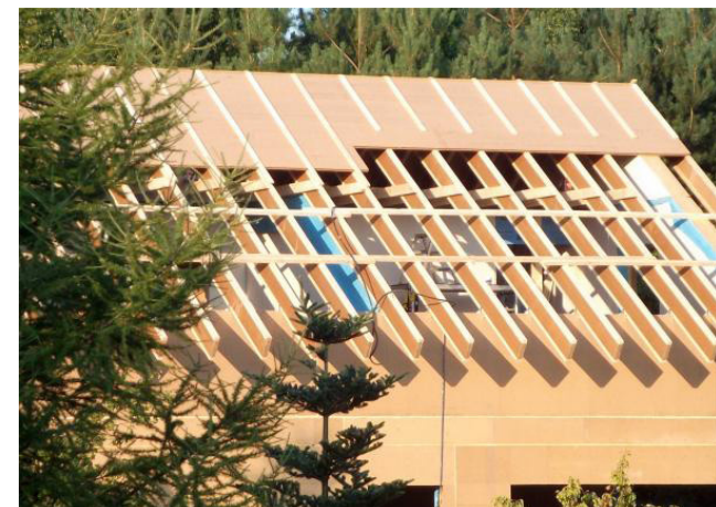
► Montaż belek STEICO + płyta STEICOuniversal
