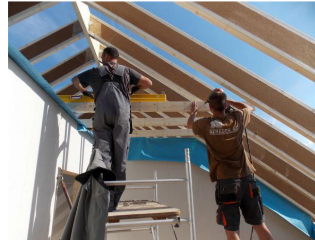
► Montaż belek STEICO
