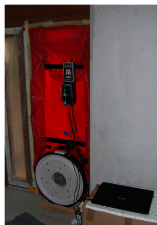
Membrana z wentylatorem do przeprowadzania testu szczelności Fot. Agnieszka Figielek
