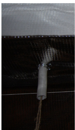
Arot - element, który wymaga uszczelnienia powietrznego
