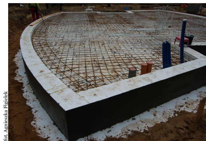
Realizacja płyty fundamentowej z wodnym systemem grzewczym.
