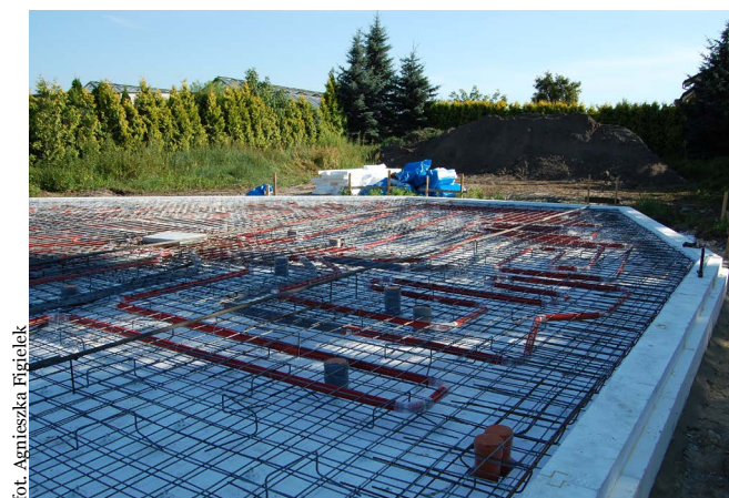
Realizacja płyty fundamentowej z powietrznym systemem grzewczym.
